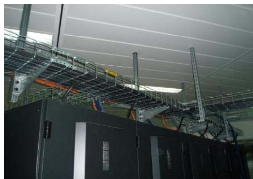
图 2 为“魔方”机房现场施工照片。
